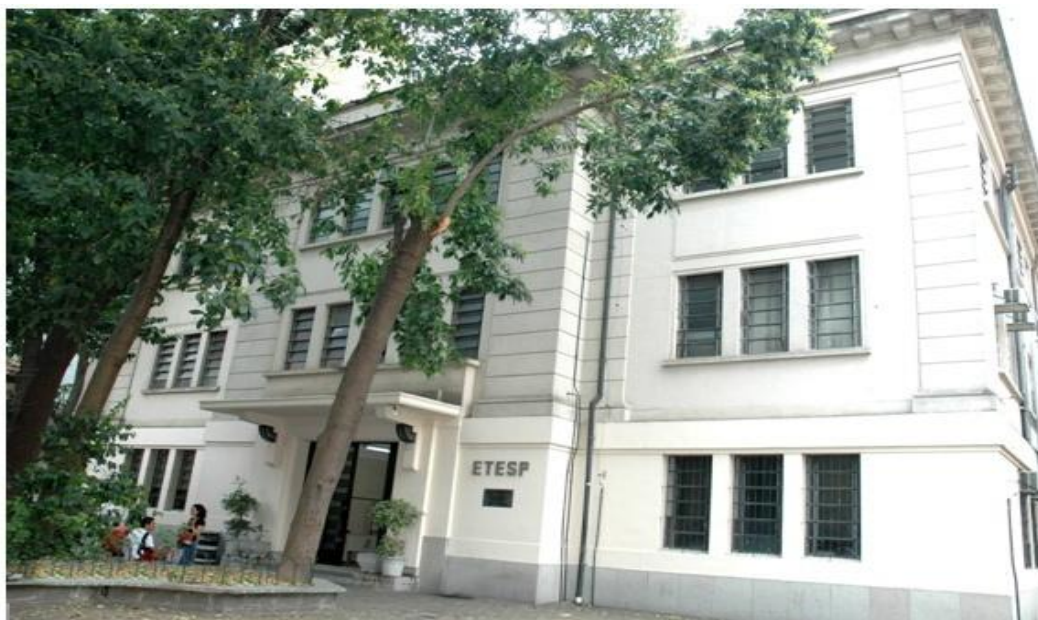
Figura 8 - Ausência de coletores seletivos na entrada principal da ETESP.
